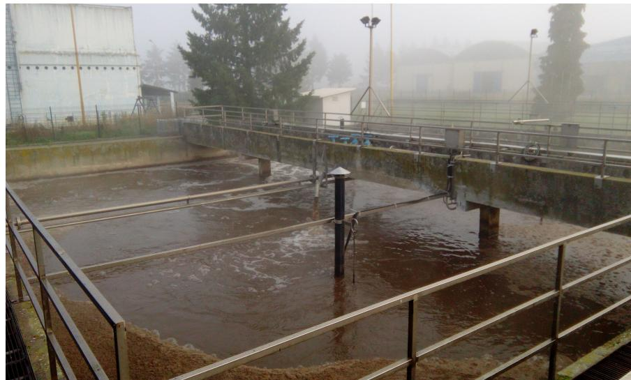
Slika 1.20. Aeracijski bazen s aeratorom pričvršćenim za metalni nosač
