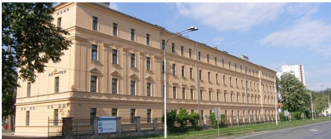
SLIKA 12. Zgrada Odjela za kemiju, Cara Hadrijana 8A, Osijek [21].
