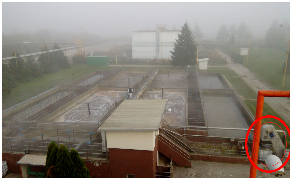
Slika 1.16. Uređaj za pročišćavanje industrijskih odpadnih voda; automatska rešetka zaokružena crveno
