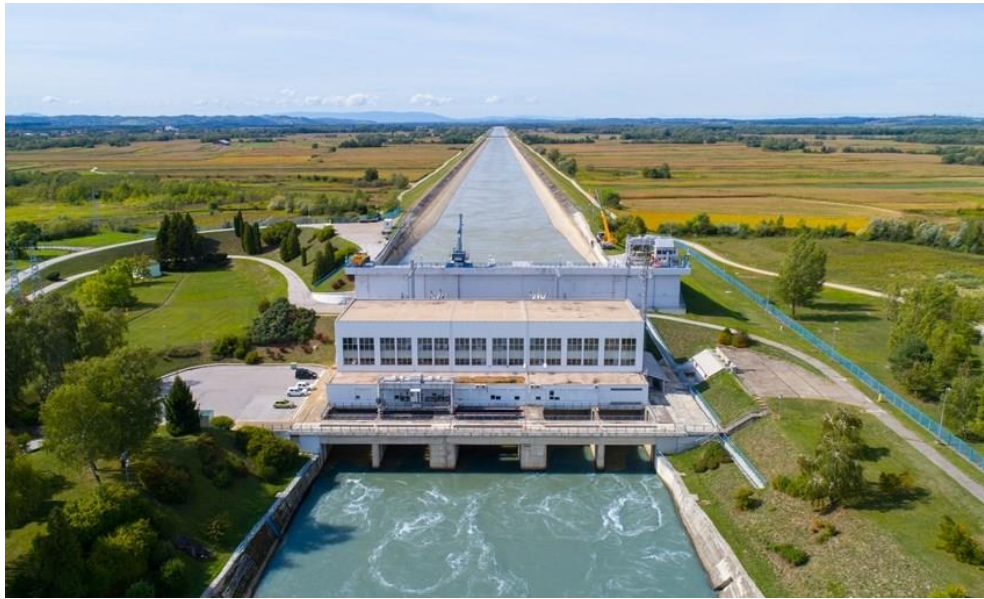
Slika 2. Hidroelektrana na rijeci Dravi u Hrvatskoj [8].
