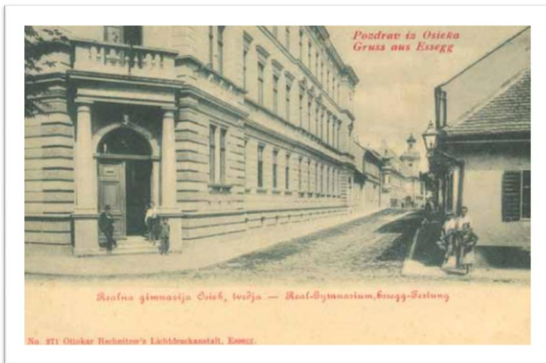
Slika 6. Realna gimnazija u Osijeku 10
