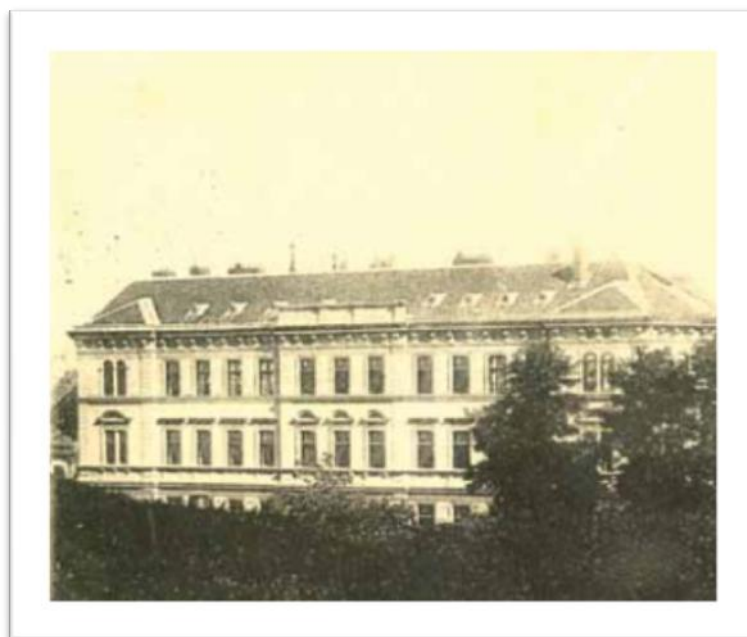
Slika 7. Realna gimnazija u Osijeku 11
