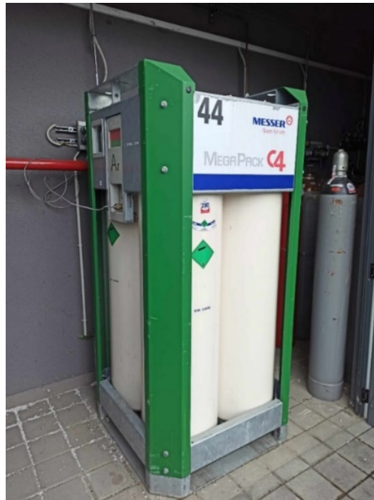
Slika 9. Spremnik argona koji je potreban za rad ICP-MS uređaja
