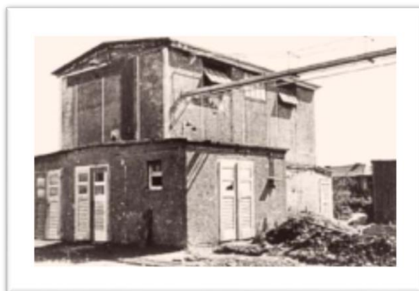
Slika 1. Zgrada prvog pogona za proizvodnju silikona
