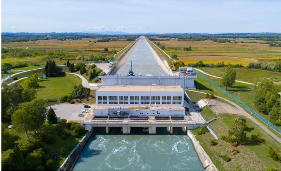
Slika 2. Hidroelektrana na rijeci Dravi u Hrvatskoj [8].
