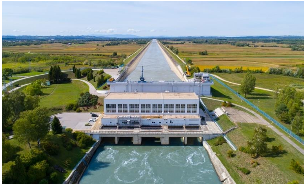
Slika 2. Hidroelektrana na rijeci Dravi u Hrvatskoj [8].
