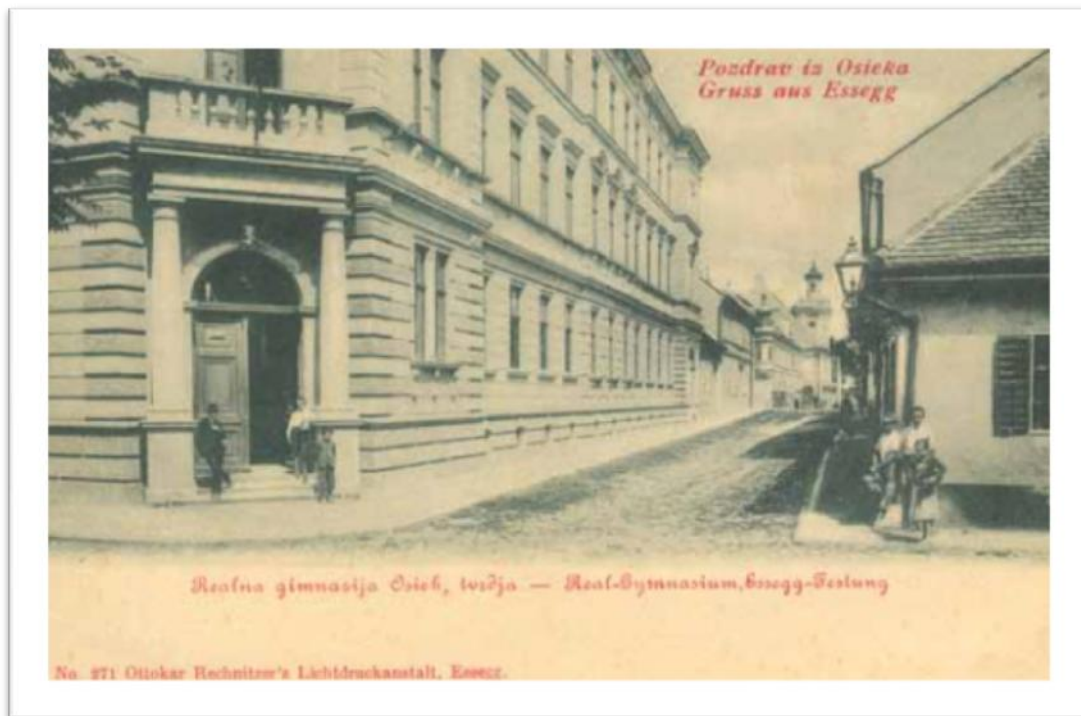
Slika 6. Realna gimnazija u Osijeku 10
