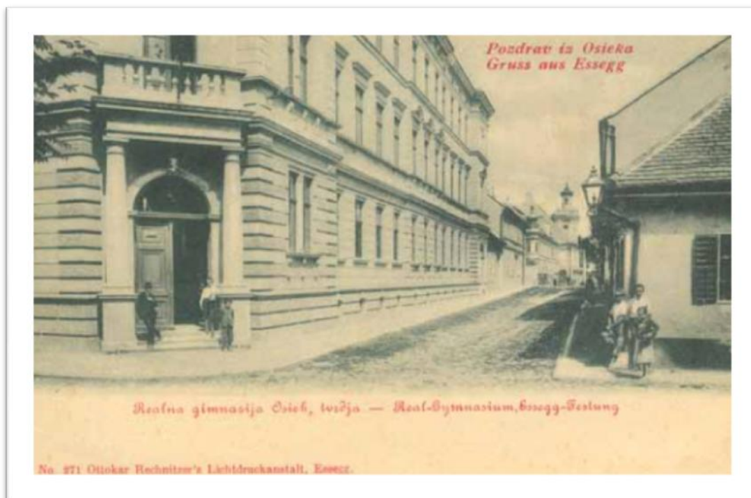
Slika 6. Realna gimnazija u Osijeku 10
