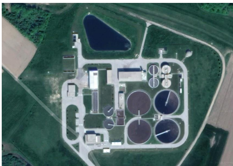
Slika 7. UPOV grada Karlovca
