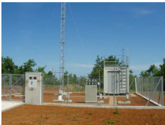
Slika 3.1.1.1. Fotografija automatske mjerne postaje Višnjan [12]
